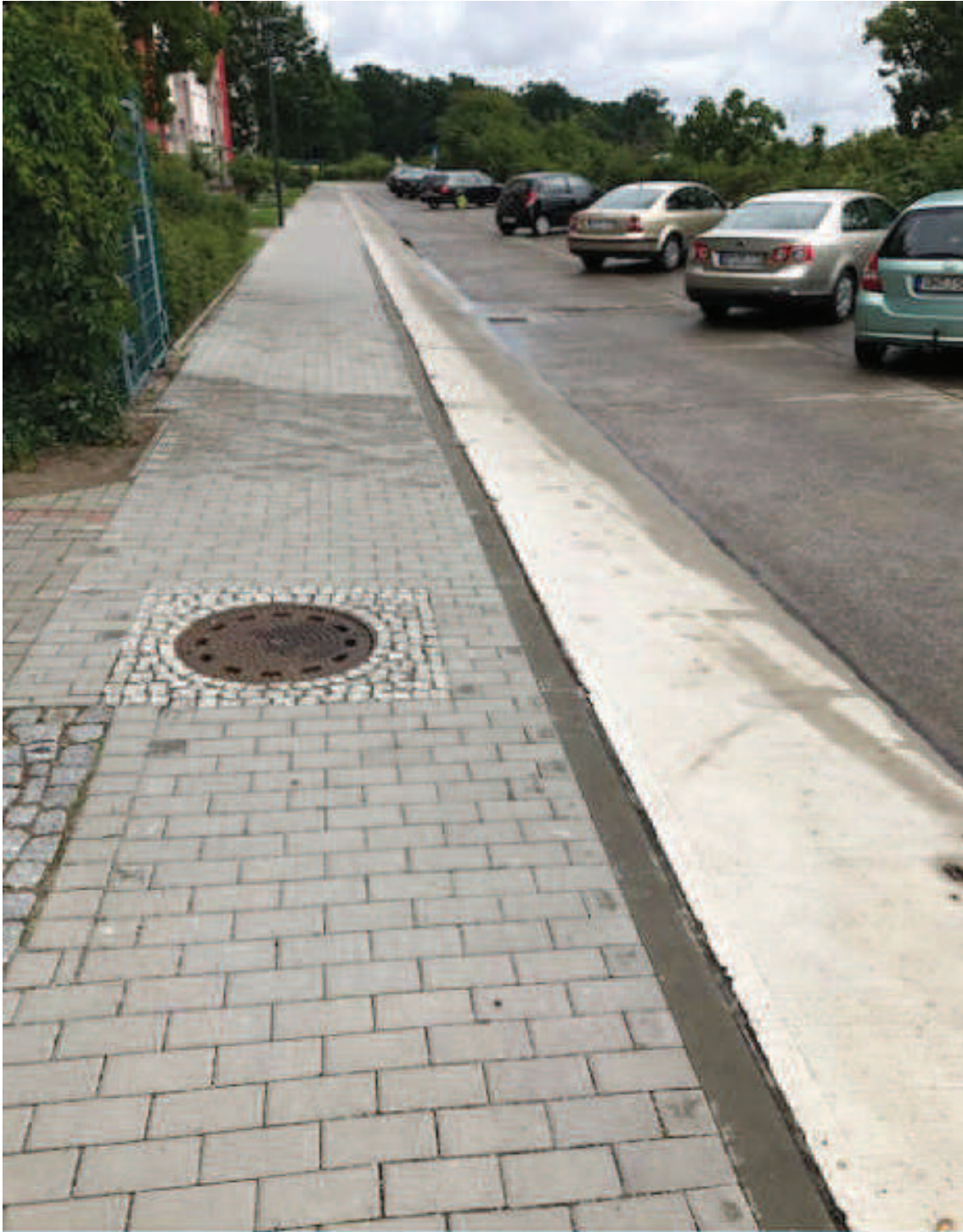
Neuer Gehweg mit verbreiteter Fahrbahn und Schrägparkern
