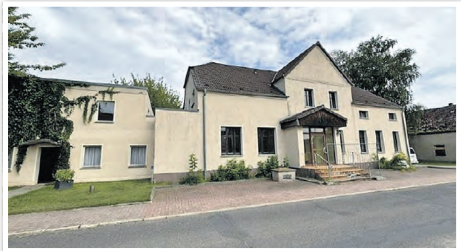
Straßenansicht bestehend aus Haupthaus und Flachdachbau
