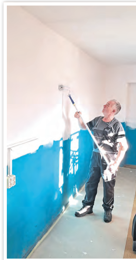
Die ersten Malerarbeiten haben bereits stattgefunden. ▶
