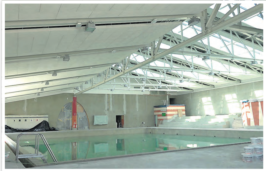
Vor der Dichtigkeitsprüfung war das Sportbecken 14 Tage lang mit Wasser befüllt.
