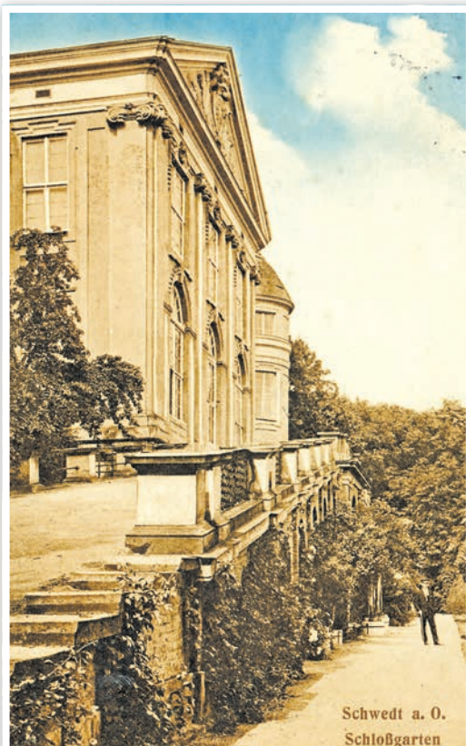
Blick auf den Schlossmittelbau von der Oderseite mit Schlossrampe 1912
