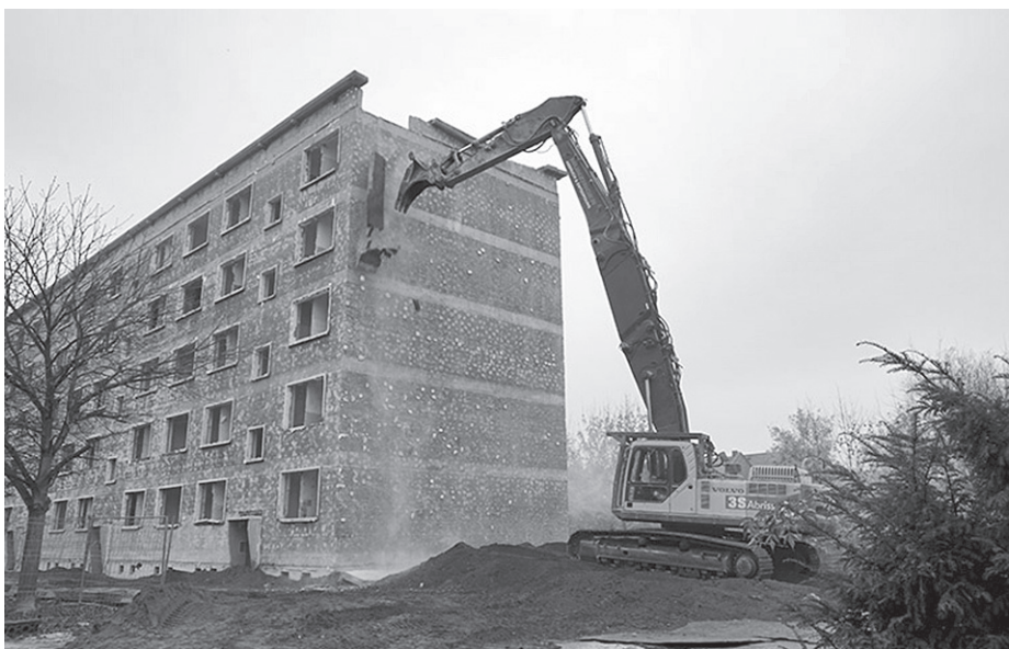
Startschuss für Quartiersumbau in der Stadt! Bis 2018 entsteht hier die Regenbogensiedlung der Wohnbauten Schwedt.
