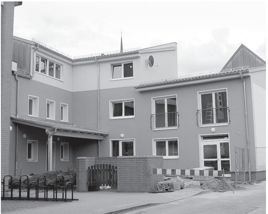
Zukünftig wird der neue Haupteingang auf der Hofseite des Gebäudes sein.
