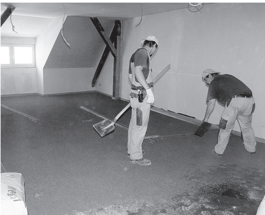
Während die Bodenleger noch Granulat aufschütten, um Unebenheiten auszugleichen, können ab September hier die Schwedter Jugendbands die Hits von morgen proben.
