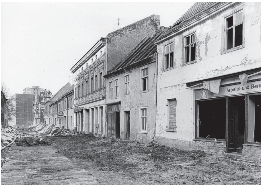
Das Foto zeigt einen Blick in die Vierradener Straße im Frühjahr 1987 während der umfangreichen Rekonstruktionsmaßnahmen.
