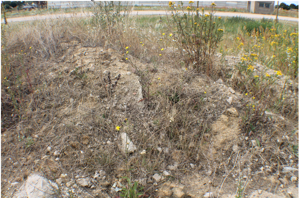
Verdichtung und Bauschuttreste mittlerer Bereich der Fläche
