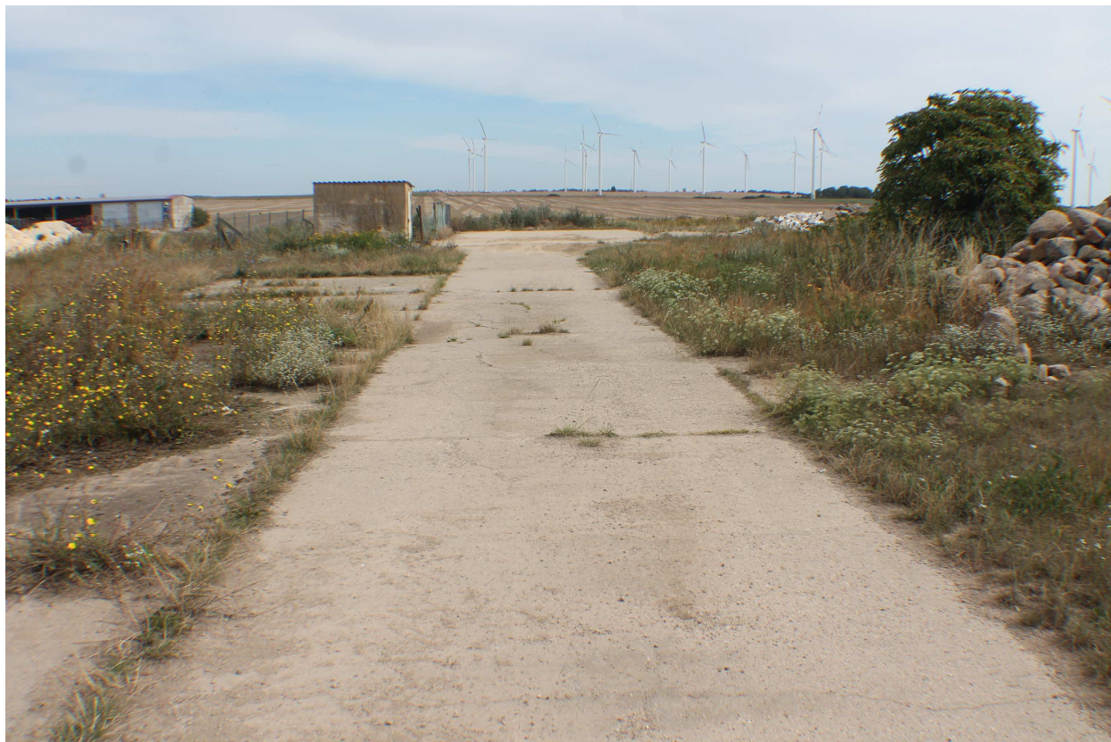
Zufahrt auf das Gelände von der Kunower Dorfstraße
