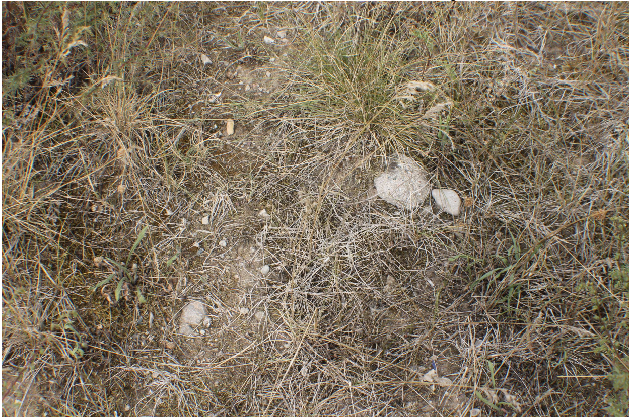
Bauschuttreste nördlicher Bereich der Fläche (beispielhaft)
